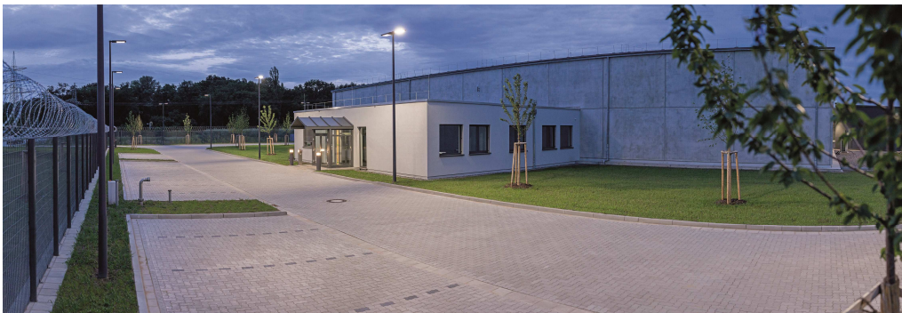
Foto 2: Das DATACENTER RHEIN-NECKAR sorgt für moderne IT-Infrastruktur in der Region
